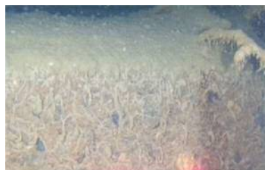
写真3 粗骨材露出の状態 Exposed coarse aggregate
